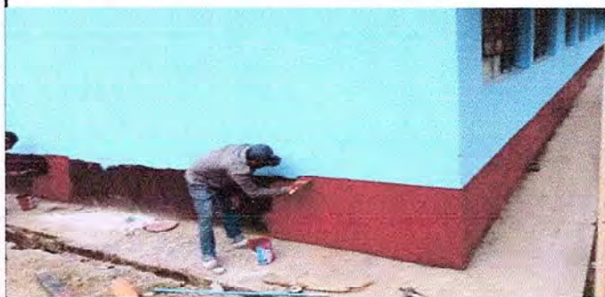
Foto 1: Se observa que la pintura del establecimiento ya esta pintada de todo las paredes al interior y al exterior en el modulo 2
