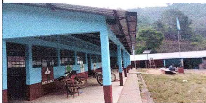
Foto 2: Se observa el canal de la escuela en buen estado en el modulo 2
