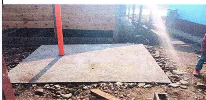
Foto 3: Se observa las maderas en buen estado en modulo 3
