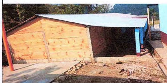
Foto 4: Se observa la bodega del establecimiento en buen estado modulo 3
